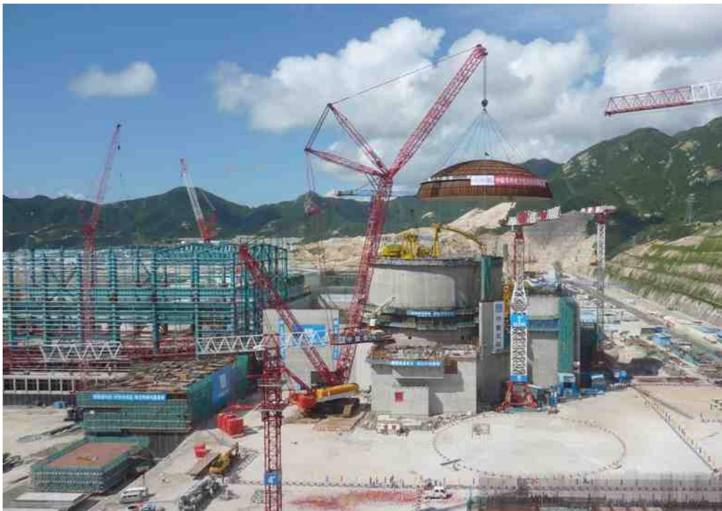
L'installation du dome de l'EPR n°2 de Taishan (ph SD EDF)
